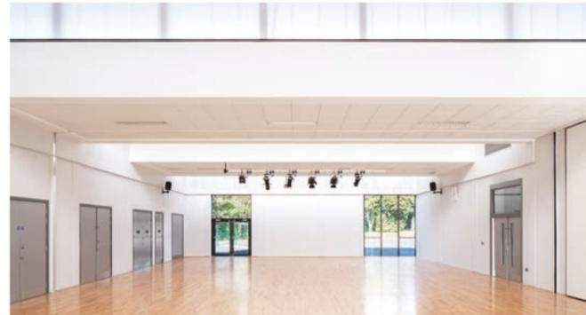
Marlon Clickfix es el sistema de acristalamiento arquitectónico que se utiliza para las fachadas verticales. Los paneles de 10 paredes de 40 mm están extruidos con un mecanismo de conexión con enclavamiento para una instalación rápida. Los paneles simplemente encajan y se fijan unos con otros sin necesidad de estructuras de acristalamiento entre paneles. El resultado es una fachada sin ninguna unión.
